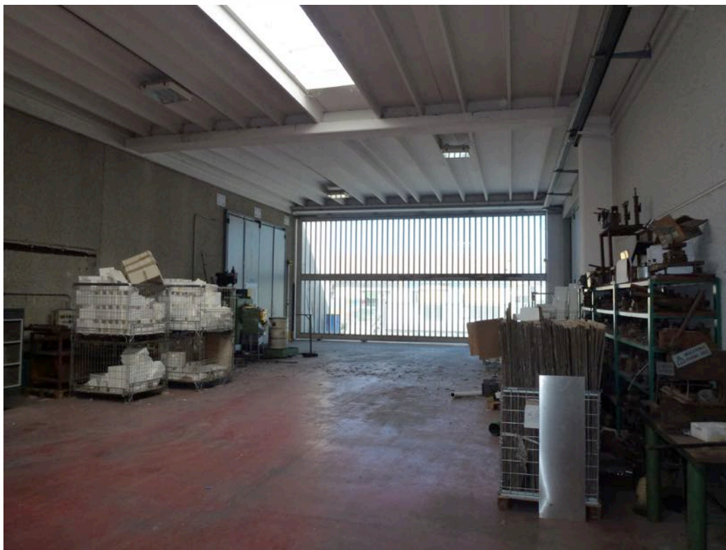
Tettoia chiusa all'estremità lato est subalterno 5
