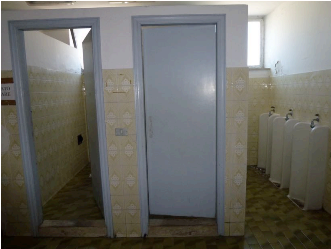
Servizi maestranze area operativa porzione storica subalterno 5
