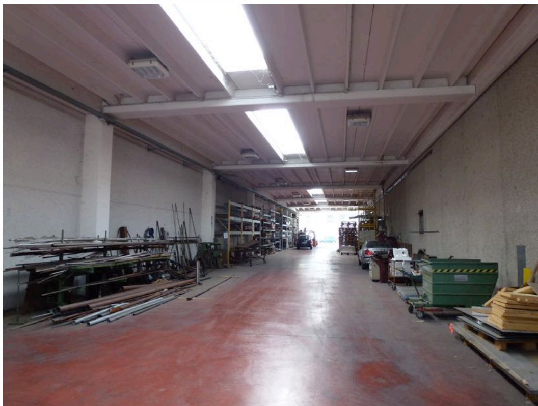
Tettoia lato ovest subalterni 5 e 6
