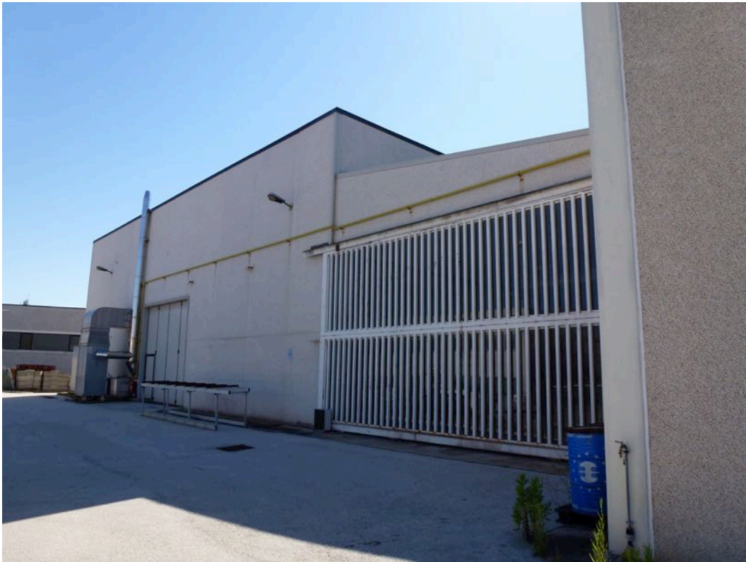
Piazzale lato est - vista infisso di chiusura tettoia all'estremità
