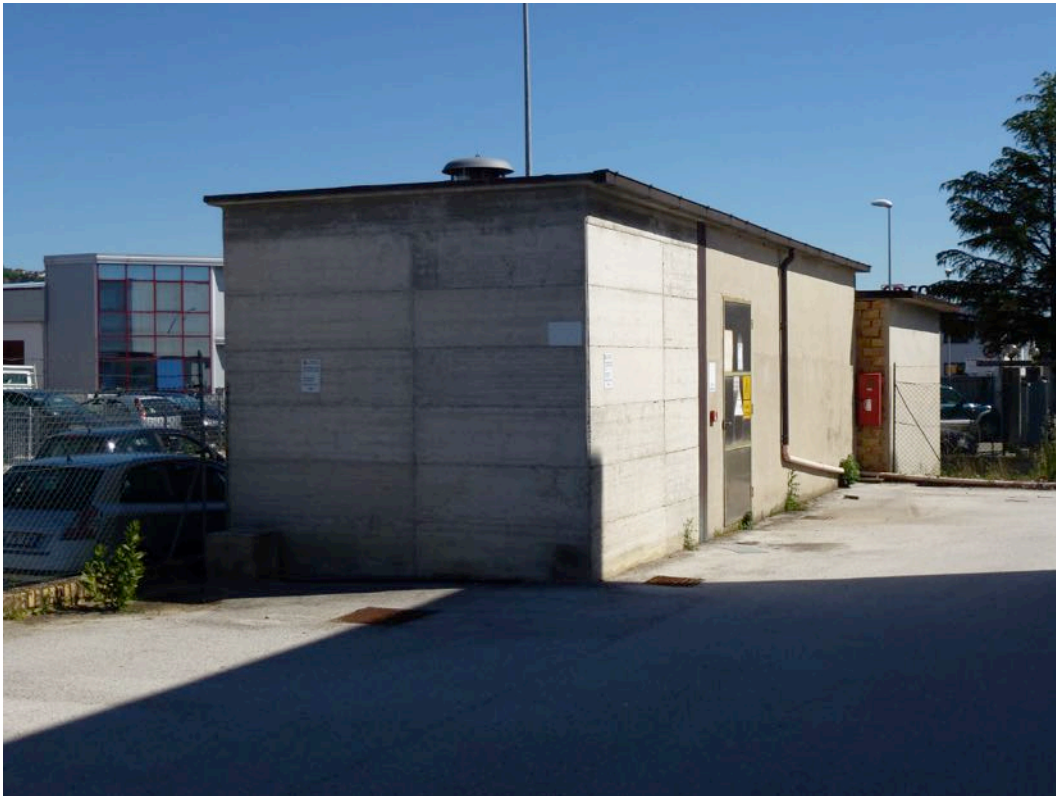
Cabina elettrica subalterno 2
