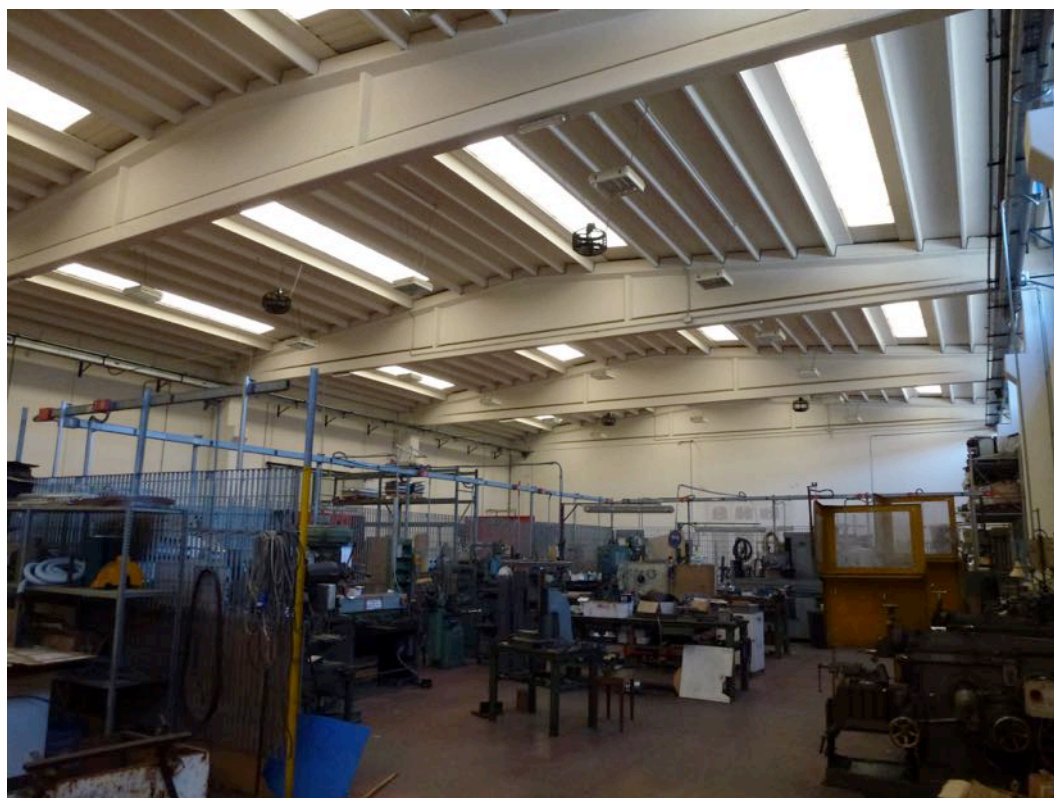
Area produttiva porzione più recente subalterno 5
