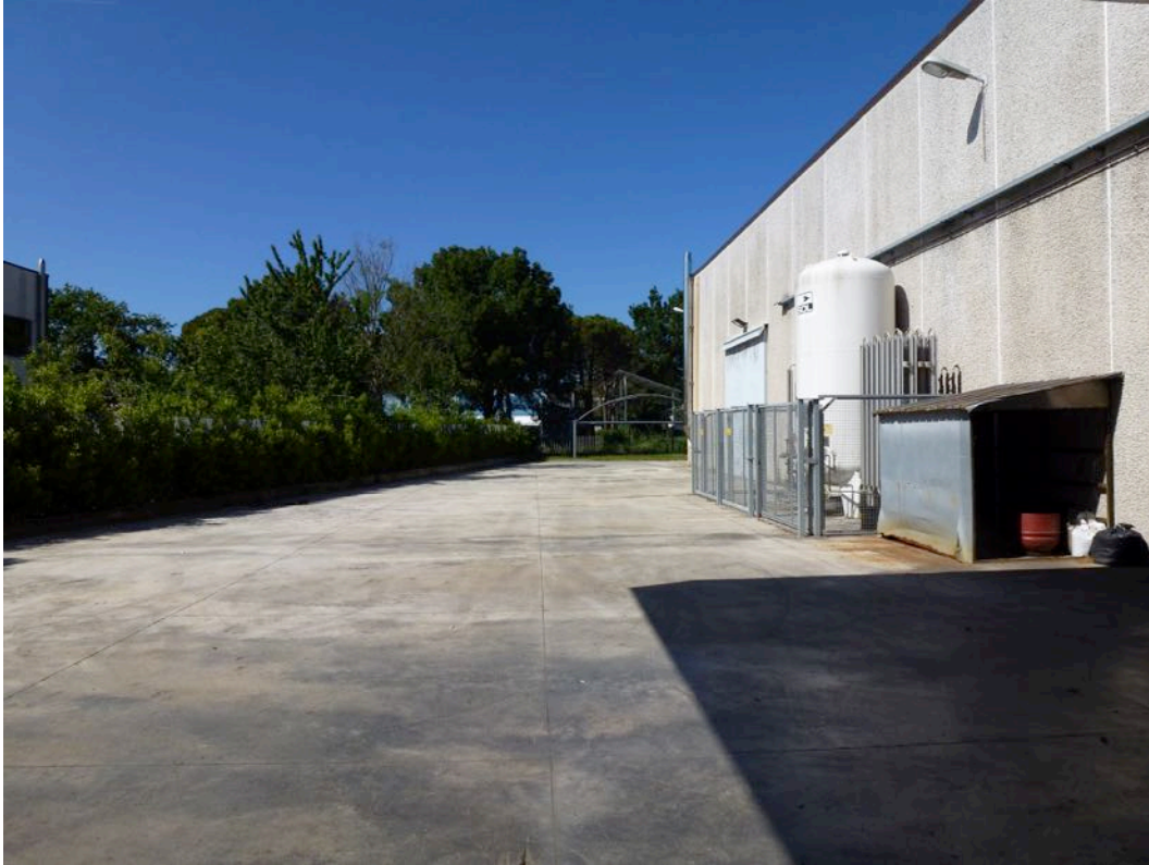
Piazzale lato ovest
