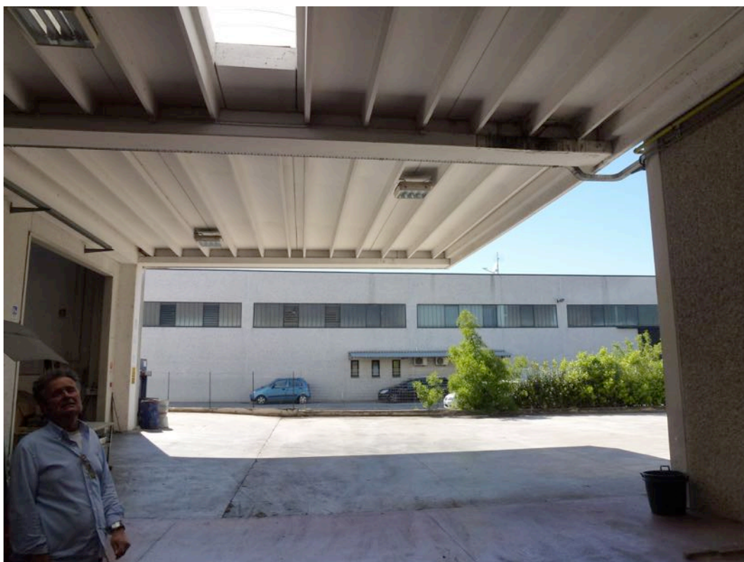
Porzione di tettoia locata subalterno 6
