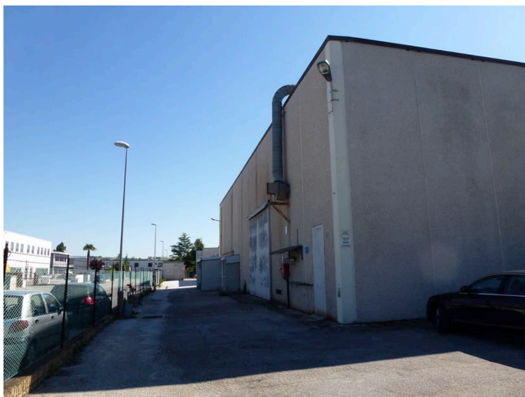
Piazzale lato est
